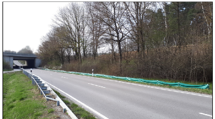
Amphibienschutzzaun vor der Unterführung der Autobahn A9 (Foto: Claus Niewierra)
